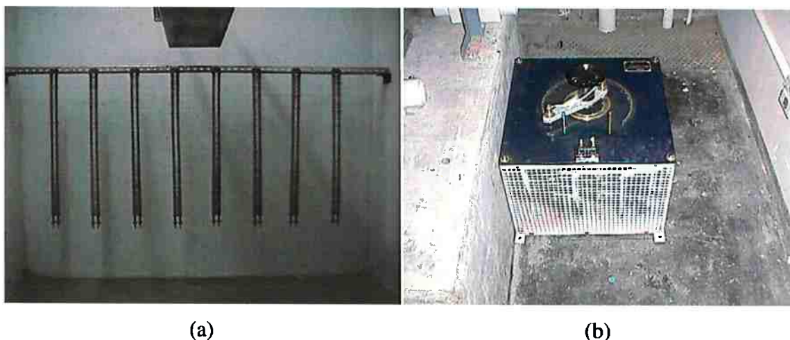
Figura 3.8. Conjunto de resistências elétricas (a) Reostato(b).
