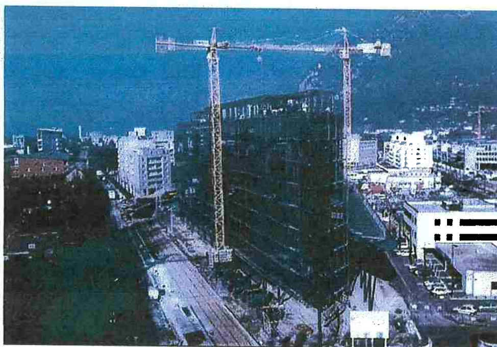
VISTA GERAL DA OBRA
