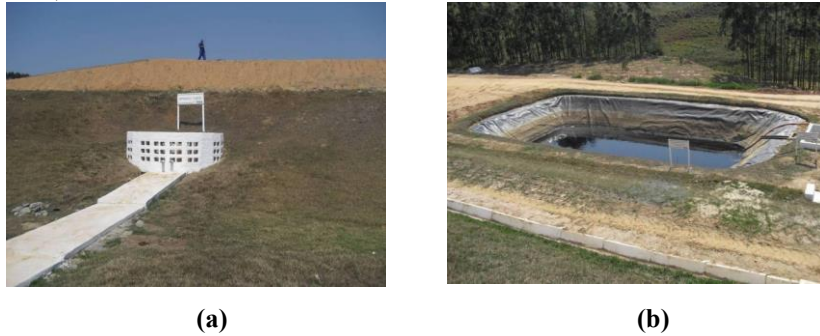
Figura 24 – (a) Poço de Captação de Líquidos Percolados (lixiviado). (b) Tanque Reservatório de Líquidos Percolados (lixiviado).
