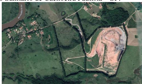
Figura 23 – Vista aérea do Aterro Sanitário de Cachoeira Paulista – SP.
