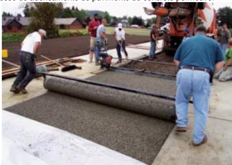
Figura 13 - Processo de adensamento de pavimento de concreto permeável
