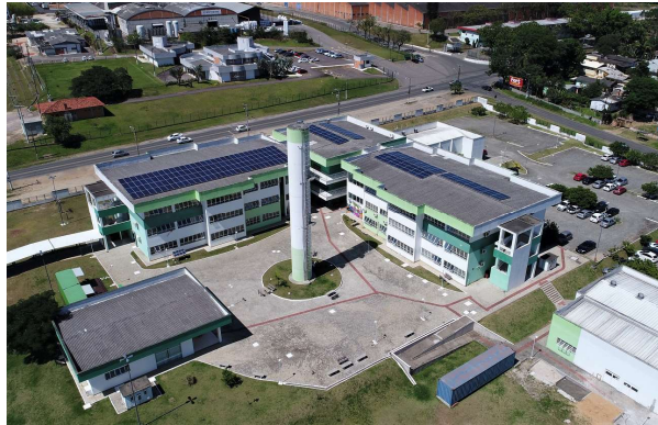
Figura 4 - Usina fotovoltaica do IFSC-1
