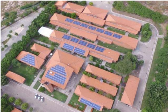
Figura 3 - Usina fotovoltaica do IFPI-1
