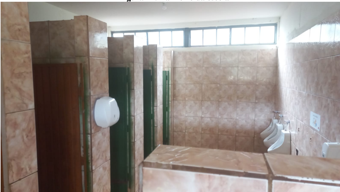
Figura 21: Banheiro da escola A
