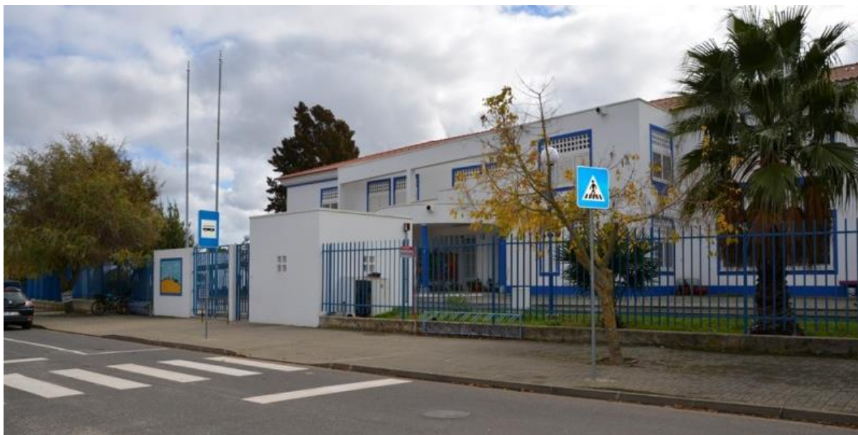
Imagem 81 - Fachada da Escola E
