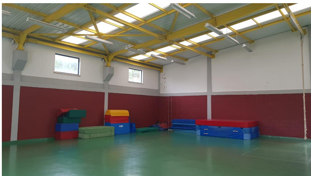
Imagem 91 - Estrutura de atletismo da Escola E
