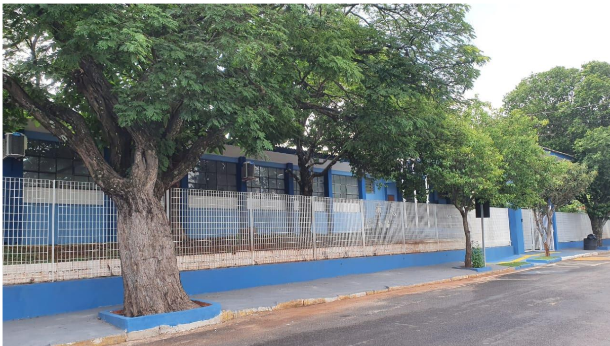
Imagem 42 - Fachada da Escola C
