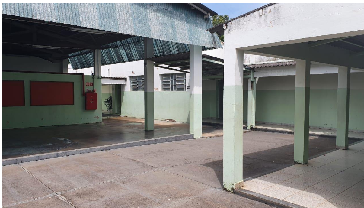
Imagem 9 - Pátio interno da Escola A
