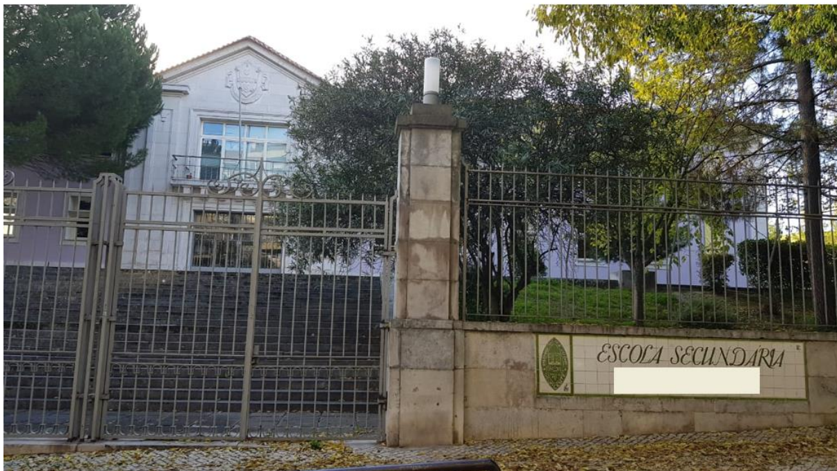
Imagem 95 - Fachada da Escola F
