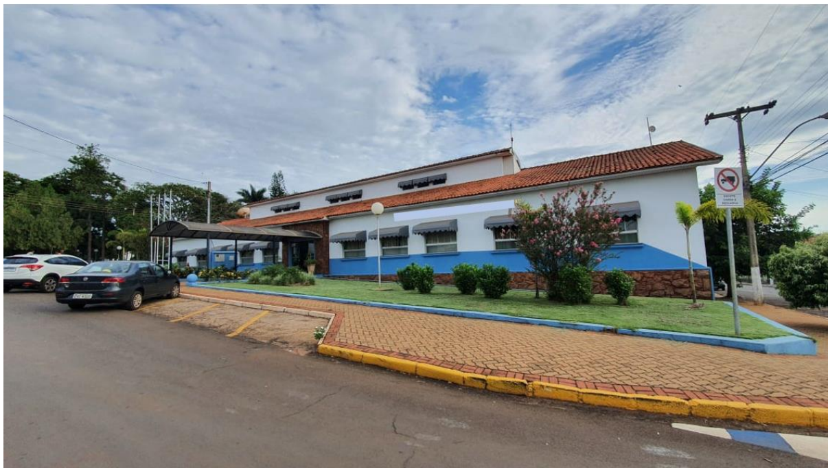
Imagem 27 - Fachada da Escola B
