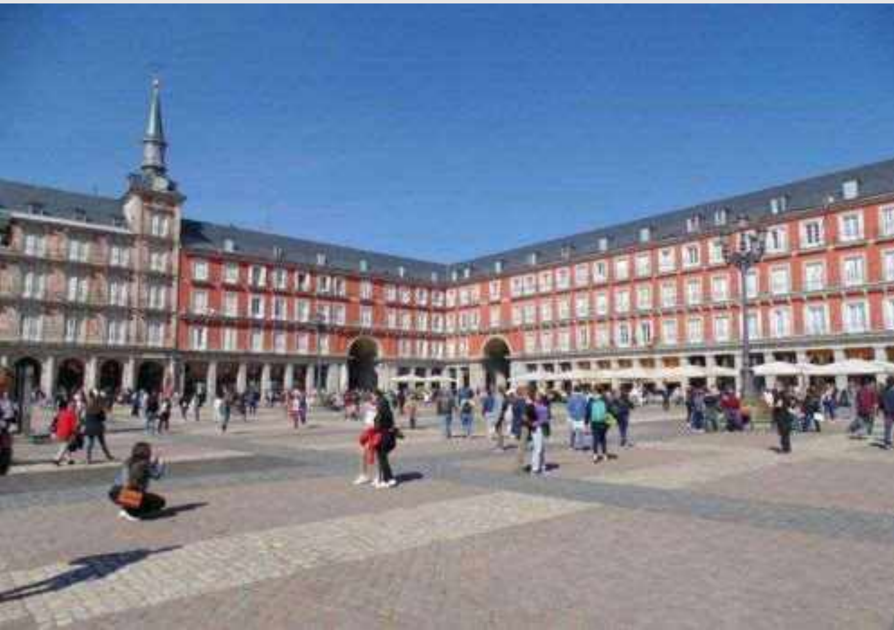
Imagem 224 – Canto nordeste da Praça Maior, onde se veem os arcos de acesso à Rua Felipe III (na fachada norte) e à Rua do Sal (fachada leste)
