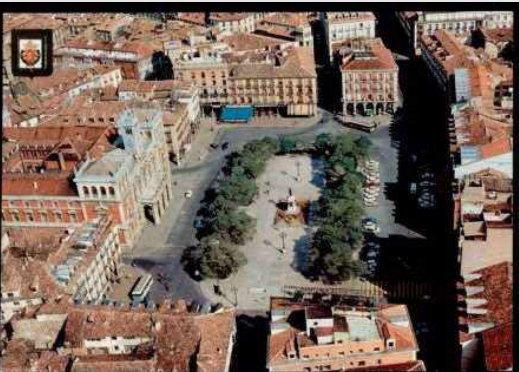
Imagem 182 – Vista aérea da Praça Maior
