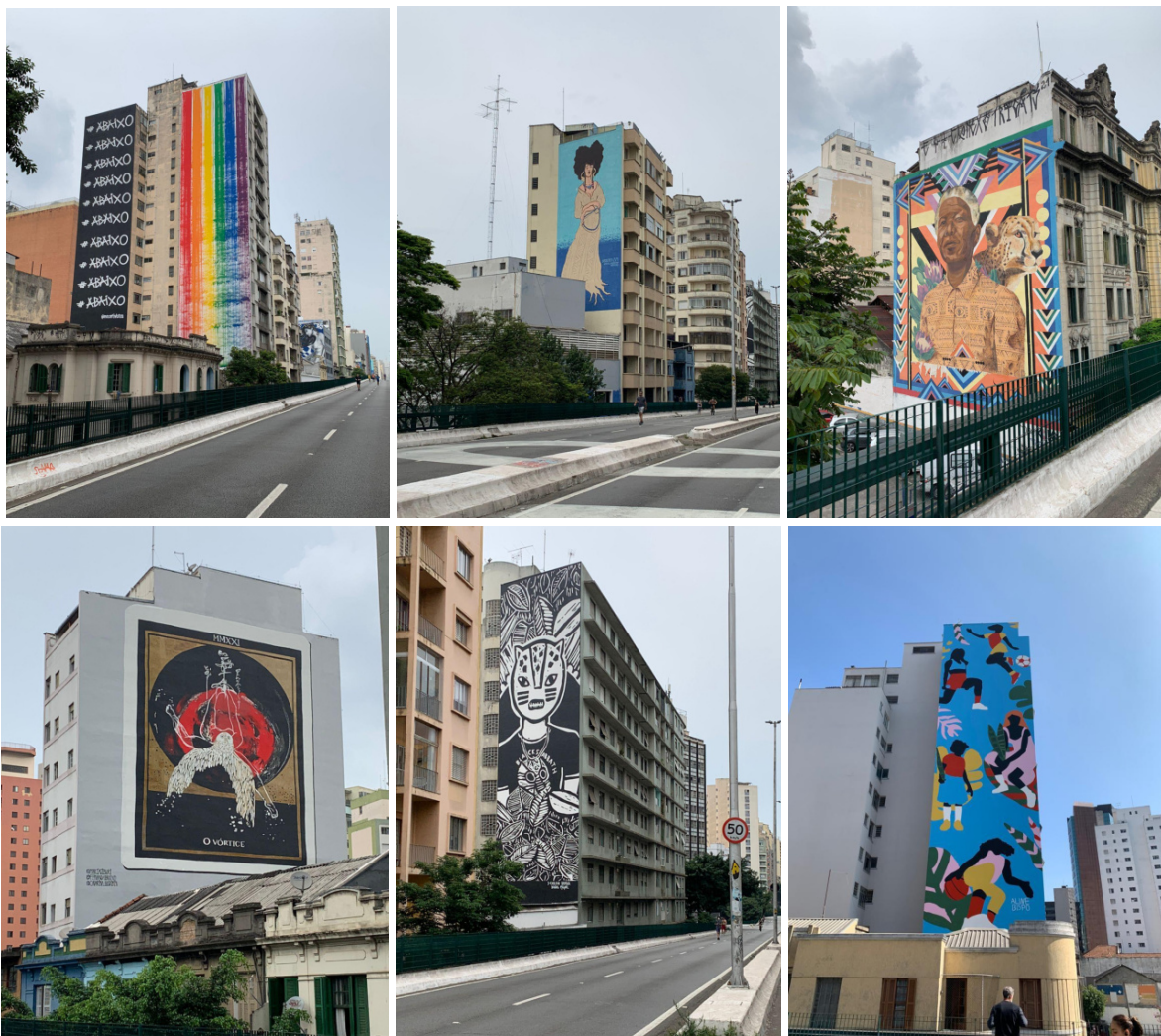
Imagens 92 a 110. Fotos dos “novos murais” nas empenas ao longo do Minhocão. Fotos do autor, feitas em fevereiro de 2023.
