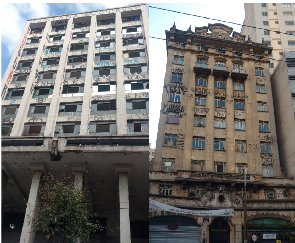
Imagem 80 – Exemplo de pixação em prédios no Centro de São Paulo com utilização da técnica de escalada pelas janelas. São Paulo, 2020
