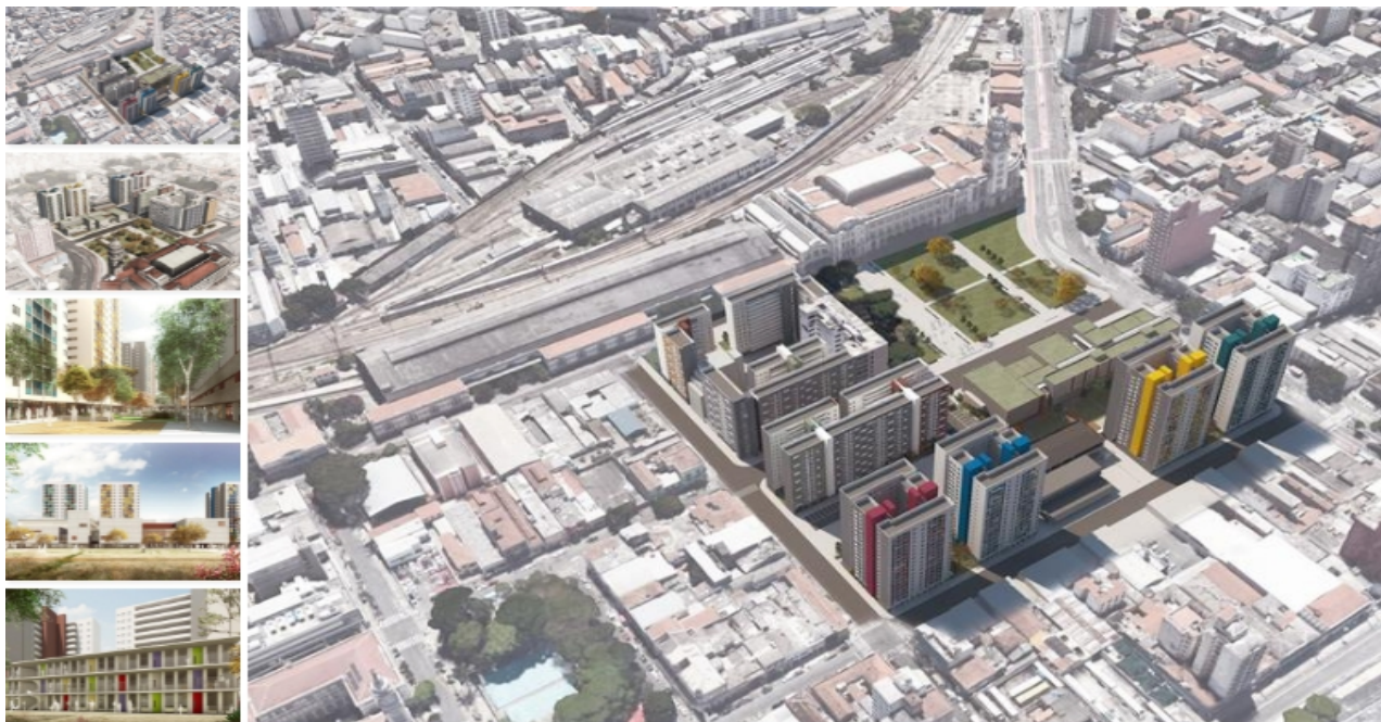
Imagem 18 – Infográfico mostra a área desapropriada no entorno da Praça Júlio Prestes cedida pelo Governo do Estado de São Paulo para implantação do PPP lote 01. São Paulo, 2017
