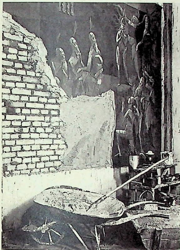
Ilustração 22 – MARCIER, Emeric. Pentecostes . 1946. Afresco – parede de tijolos preparada com argamassa para receber a pintura. Foto (1946). Acervo Matias Marcier.
