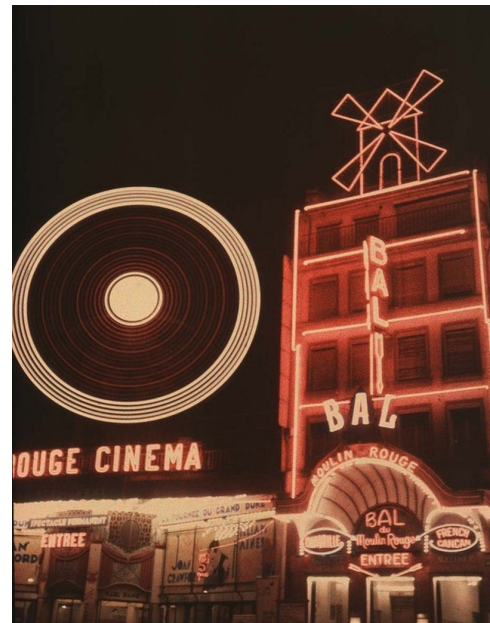
FIGURA 13: MOULIN ROUGE, C. 1930, JÁ COM A INTENSA INTERVENÇÃO DO NEON
