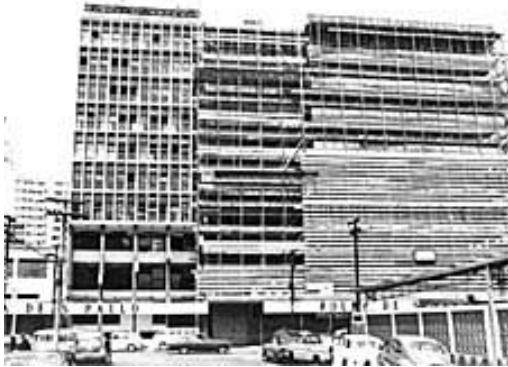
Figura 19 – Construção da nova sede do Grupo Folhas, à Alameda Barão de Limeira, em 1950
