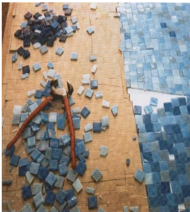
Figura 50: Montagem das tésseras do Edifício Exclusive , 2003 [2]
