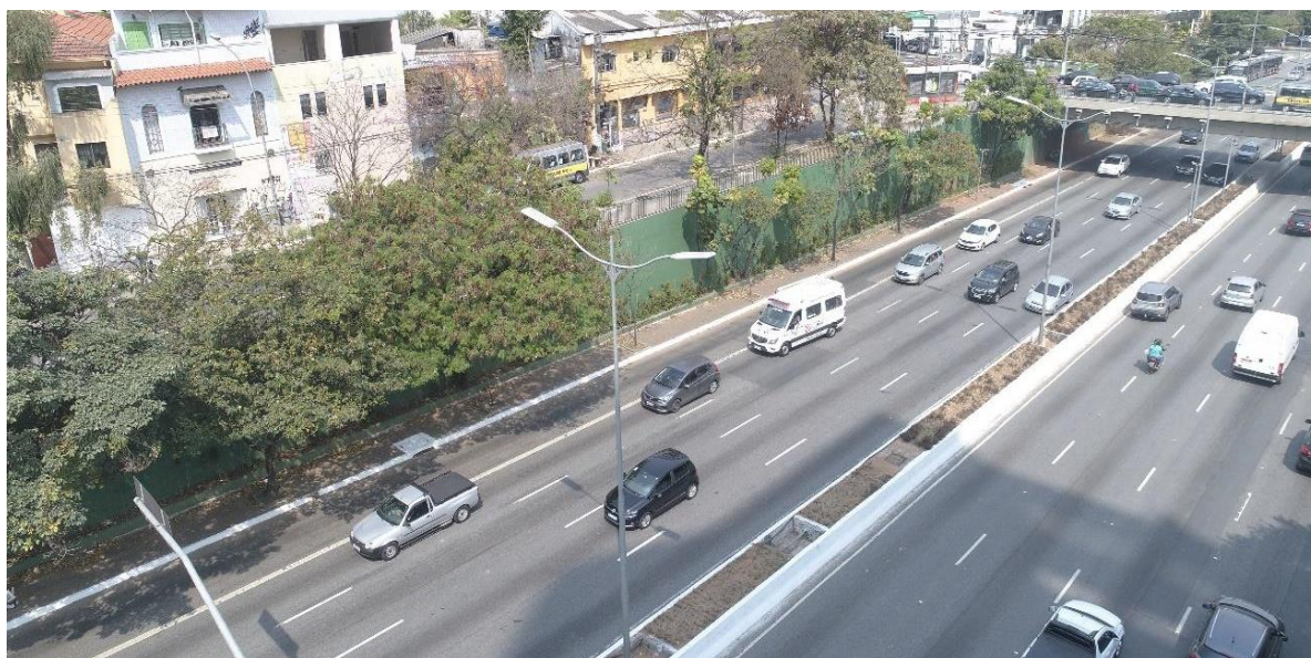
Figura 37: Jardim vertical e muros do Viaduto Tutóia, Avenida 23 de Maio, 2021
