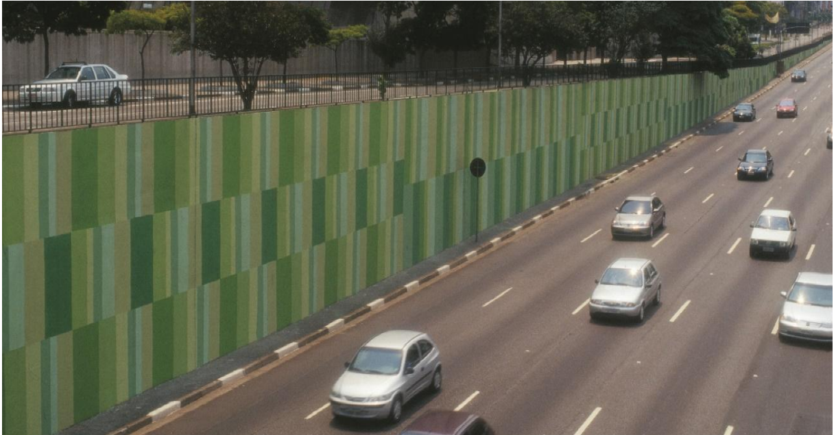
Figura 35: Claudio Tozzi. Mural do Viaduto Tutóia, Avenida 23 de Maio, 2004 [1]
