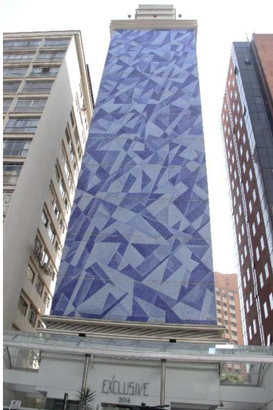
Figura 47: Vista frontal da fachada do Edifício Comercial Exclusive , 2003
