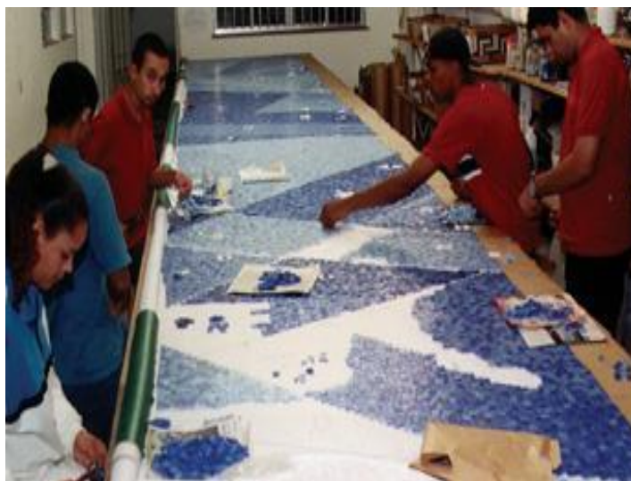
Figura 49: Montagem das tésseras do Edifício Exclusive , 2003 [1]
