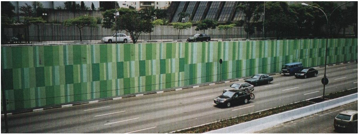
Figura 36: Claudio Tozzi. Mural do Viaduto Tutóia, Avenida 23 de Maio, 2004 [2]
