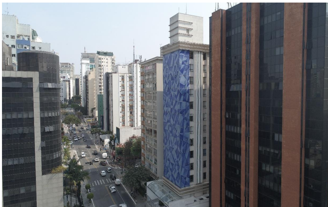
Figura 48: Vista da região onde está localizado o Edifício Exclusive , 2003
