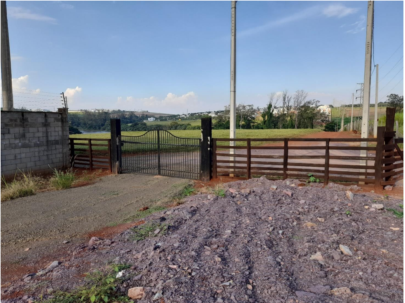
Figura 33 - Portão de metal e cerca de madeira fechando o acesso usado há décadas pelos moradores do Santa Rosa para chegar na Lagoa do Santa Rosa, ao fundo. Fonte: Foto do autor, 05 abr. 2023
