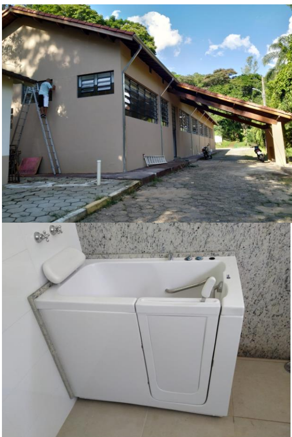
Figura 95 - Instalações do Balneário de Amparo em construções (esquerda)
