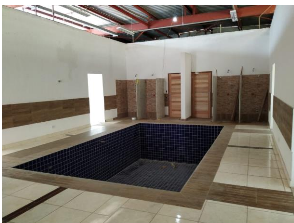
Figura 119 - Vista de parte do Complexo Termal de Poá, em obras (esquerda)
