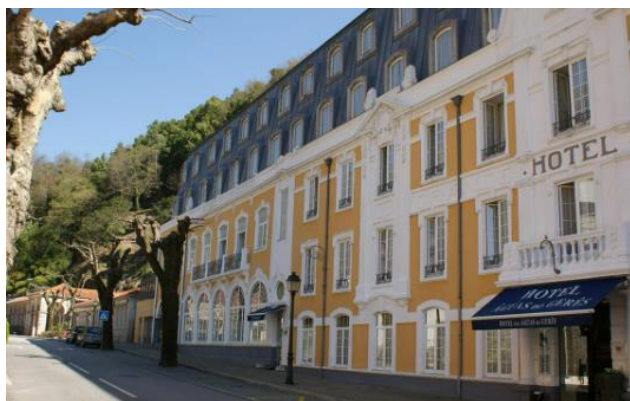
Figura 26 - Frente do Hotel Águas do Gerês Fonte: ATP, 2023
