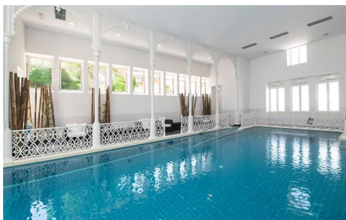
Figura 35 - Piscina termal das Termas do Luso Nota: Piscina projetada por Eiffel (TERMAS DO LUSO, 2023). Fonte: ATP, 2023
