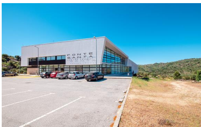
Figura 43 - Termas de Almeida Fonte Água Santa Fonte: ATP, 2023
