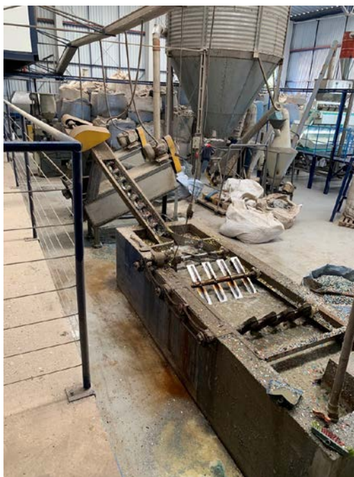
Figura 56. Tanque de decantação Fonte: Autora
