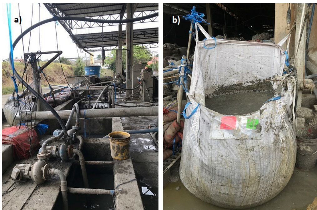
Figura 44. a) Sistema de tubulação para coleta das impurezas provenientes da etapa de lavagem; b) Bag de acondicionamento do lodo proveniente da lavagem Fonte: Autora
