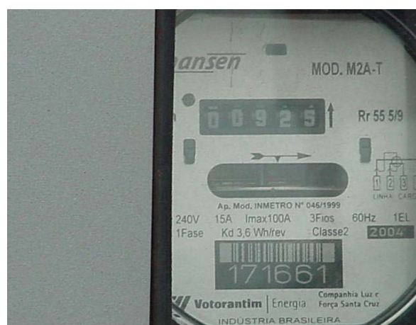
Figura 10.4 Consumo de uma unidade rural em Ribeirão Claro – PR no segundo mês após a ligação pelo Programa Luz para Todos. Consumo de 925kWh
