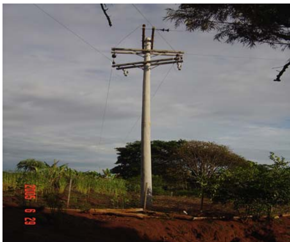
Figura 10.5 Rede existente, montada no Programa Luz da Terra e aproveitada no Programa Luz para Todos em Santa Cruz do Rio Pardo – SP
