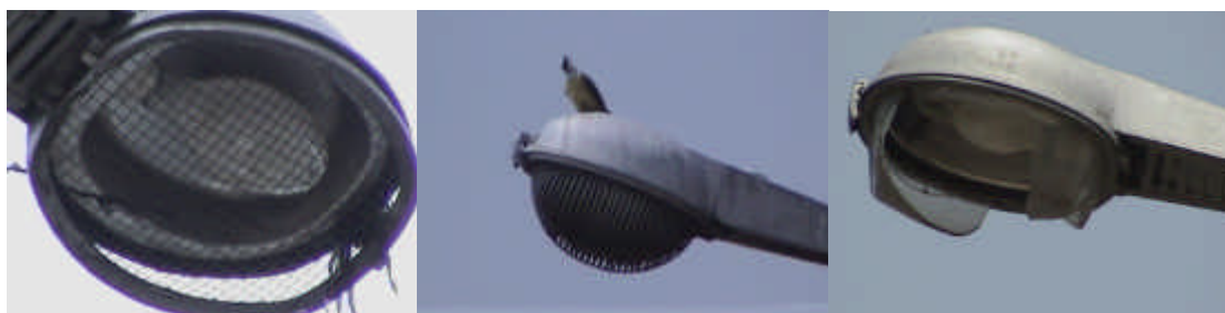
Figura 3.3 – Imagens de instalações na CUASO/USP, com artifícios para prevenção e resultado de vandalismo. Fotos do autor, 2000.
