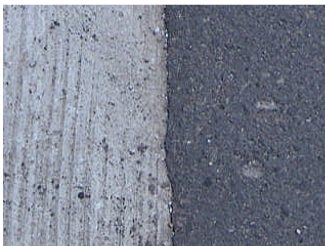
Figura 3.14- Pavimento em concreto (pedra com cimento) e asfalto (pedra com piche). Trecho norte do Anel viário Mario Covas, em São Paulo, 2002.
