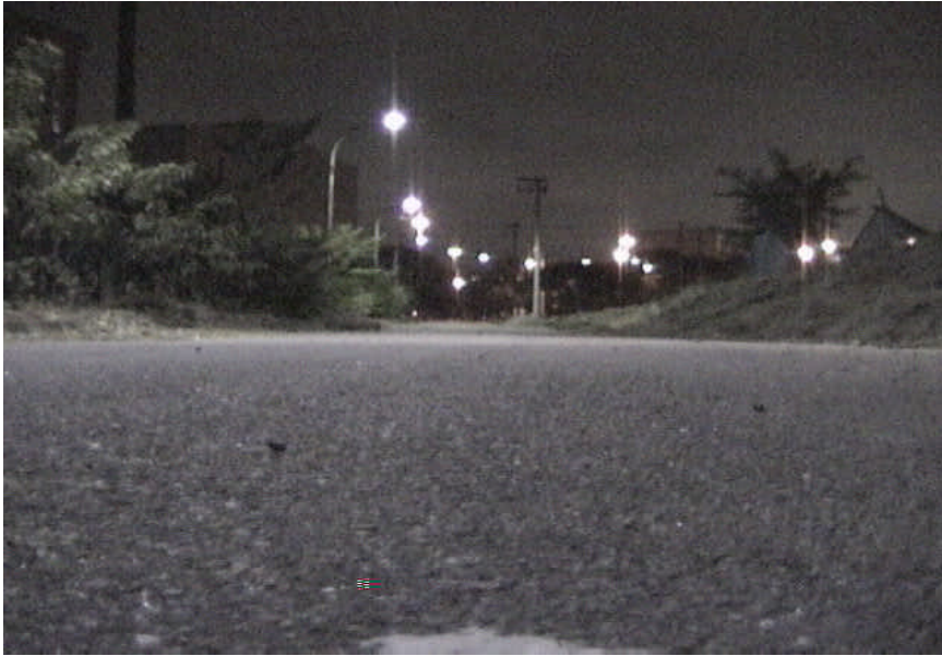
Figura 2.50 – Via do experimento na CUASO/USP com instalação utilizando lâmpadas com multivapores metálicos (proposta de continuidade do trabalho). No Brasil foram obtidos resultados para análise de desempenho de sistemas, sendo um com MVM 250 W (100 %). Fonte: Foto do autor.
