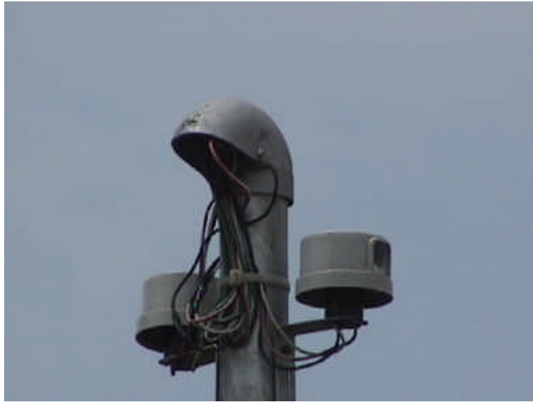
Figura 2.28 – Relé fotoelétrico convencional para comando da IP, com instalação independente dos postes da distribuição de energia elétrica.
