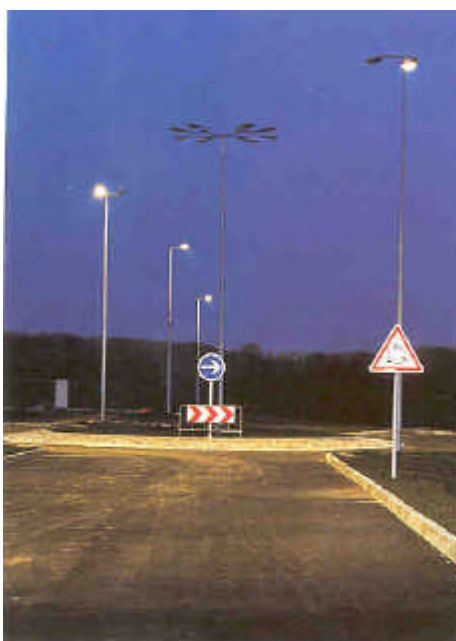
Figura 1.4 – Instalação de IP com controle pelo desligamento de uma das duas fontes. Fonte: Scan, 2000.
