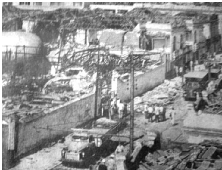
Figuras 8 - Vista do gasômetro após o acidente
