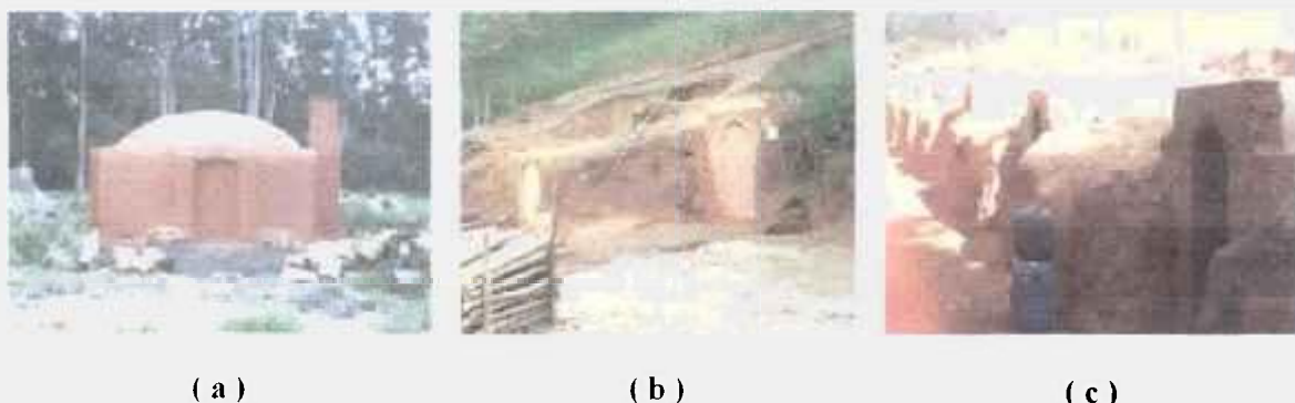
FIGURA 8 – Tipos de fornos de alvenaria: (a) rabo quente, (b) forno de encosta e (c) forno de meio encosta (Brito, 2000).
