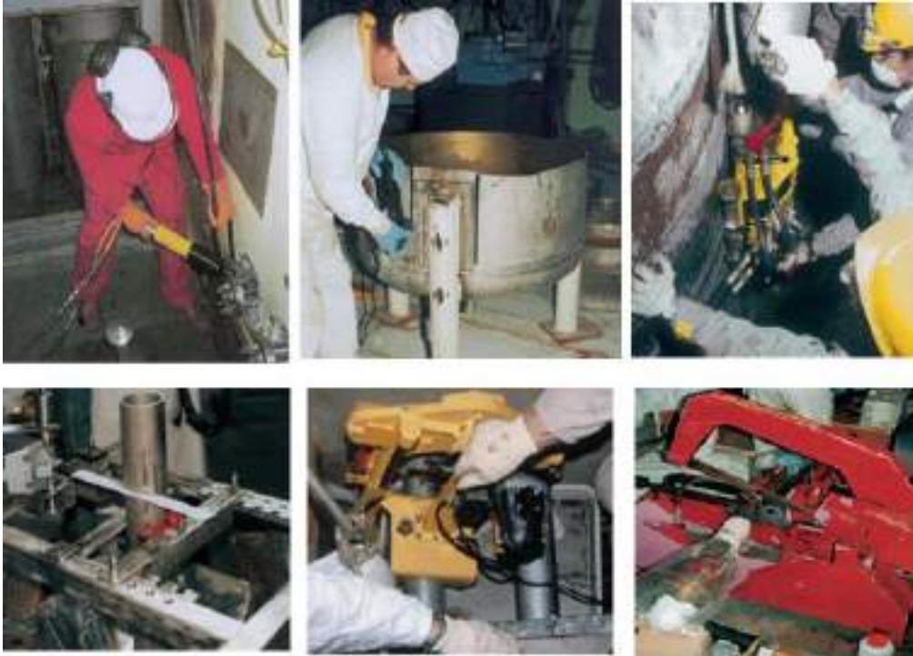
Figura 31- Técnicas de desmantelamento
