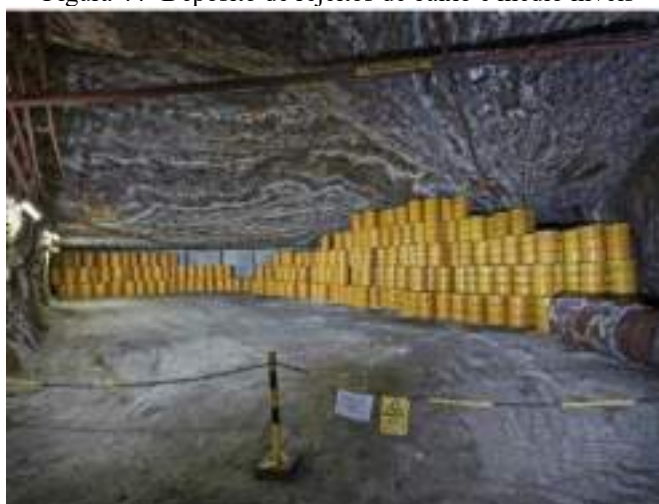
Figura 44- Depósito de rejeitos de baixo e médio níveis
