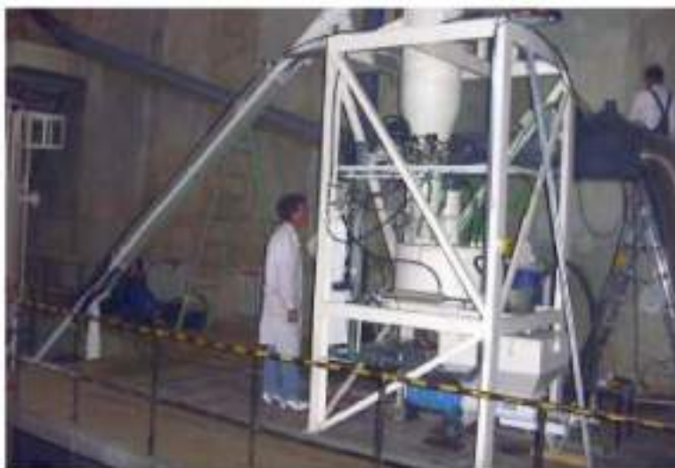
Figura 29- Instalação da planta de cimentação em preparação para o descomissionamento
