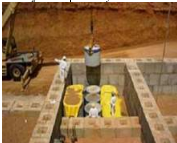
Figura 42- Depósito de rejeitos em aterro
