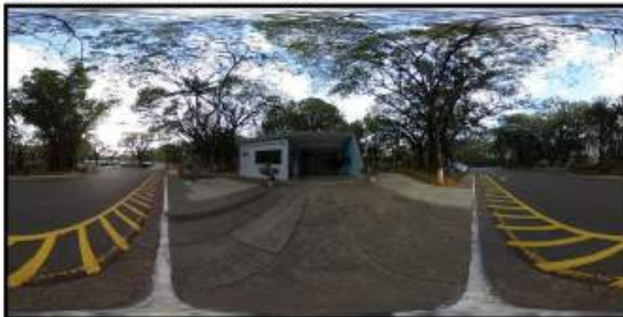
Figura 2 – Foto 360 graus da entrada do prédio do reator EA-R1
