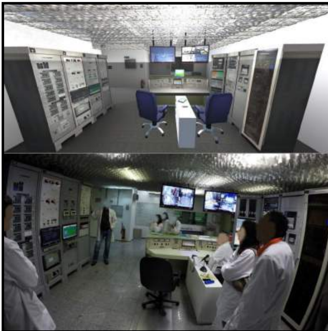
Figura 28 – Sala de controle do reator IEA-R1 vista do fundo – comparação (modelado e real)
