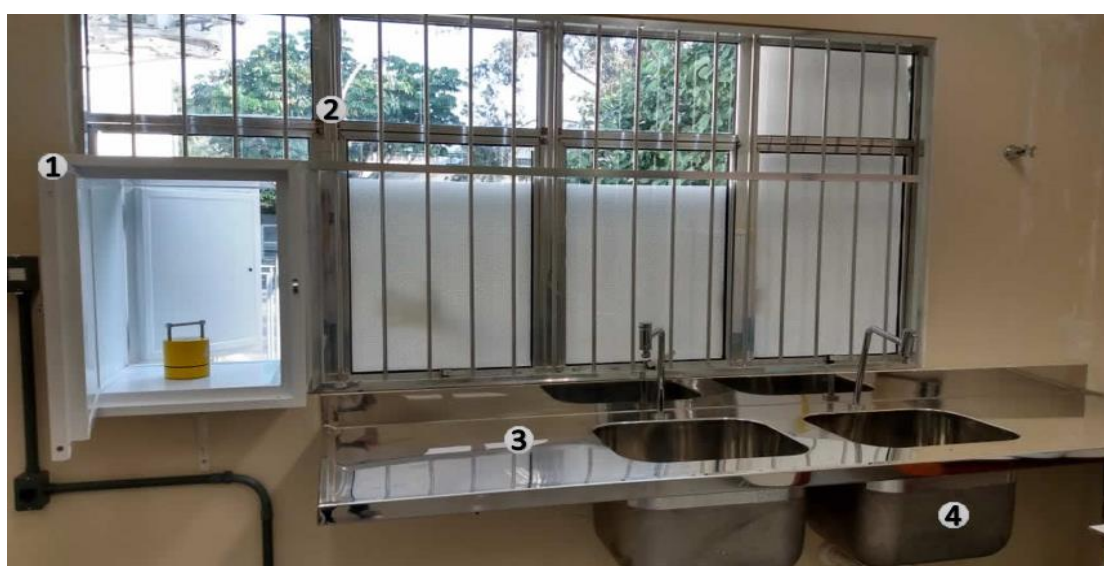
Figura 19 – Modificações e instalações realizadas para o funcionamento adequado do novo laboratório. 1 - Pass-through de chumbo; 2 - Janelas com grades; 3 - Bancada com superfície de aço inoxidável; 4 - Cubas com 40 cm de profundidade.
