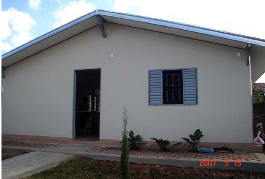
FIGURA 5.2 - Vista externa da residência construída com placas pré-fabricadas de fosfogesso.
