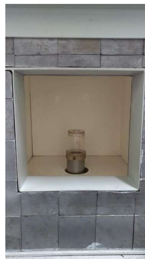
(b) Vista interna à blindagem de chumbo.
