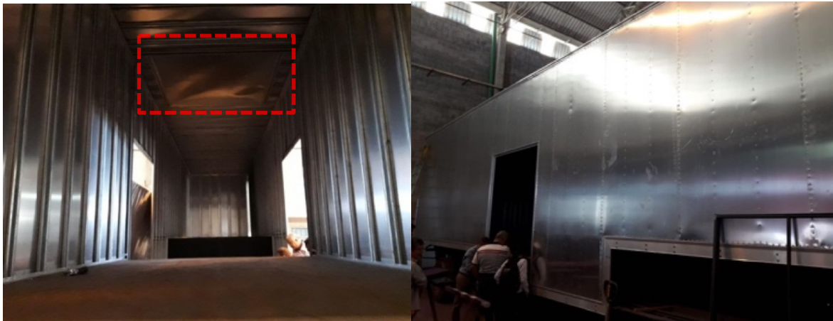
Figura 26. Unidade móvel com a vedação externa em chapas lisas de alumínio.
