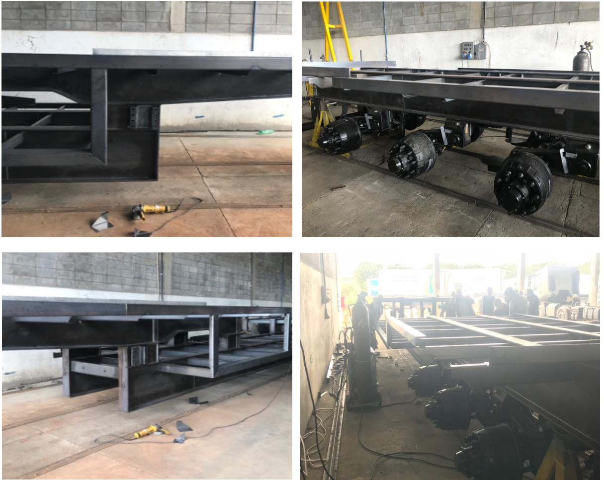
Figura 25. Confeção da estrutura metálica (chassi) da unidade móvel pela empresa Truckvan.
