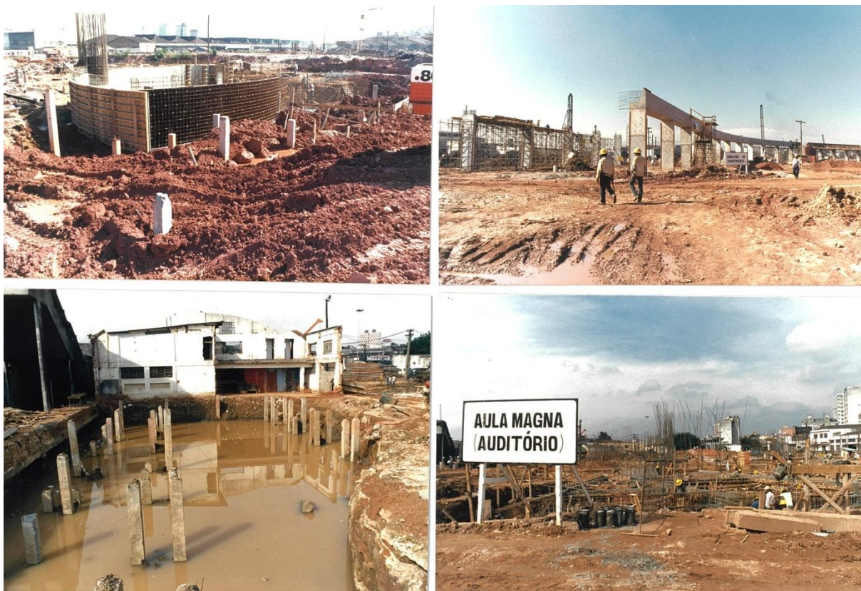
Imagem 15: As entranhas do Memorial em construção
