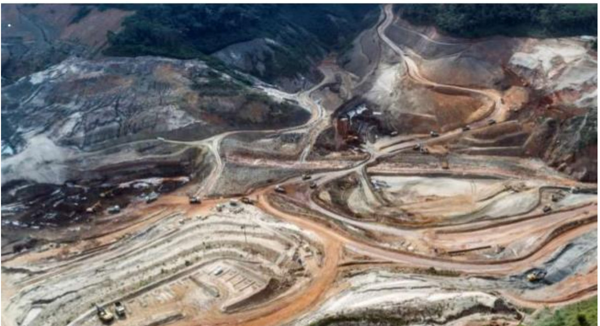
Fig. 1 - Barragem do Fundão, na região de Mariana-MG, após o rompimento
