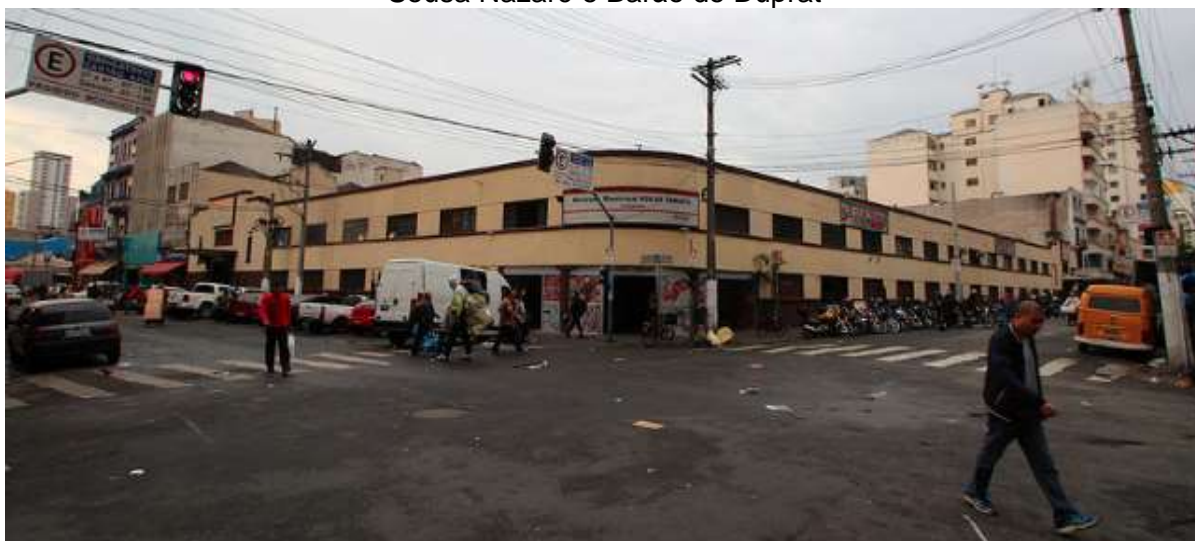
Figura 15: Fachada do Mercado Kinjo Yamato, entrada no cruzamento das ruas Carlos de Sousa Nazaré e Barão de Duprat
