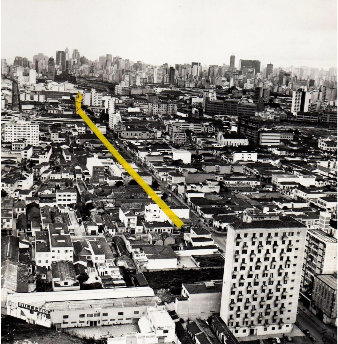
80 - Rua dos Italianos, esquina com a rua Javaés
