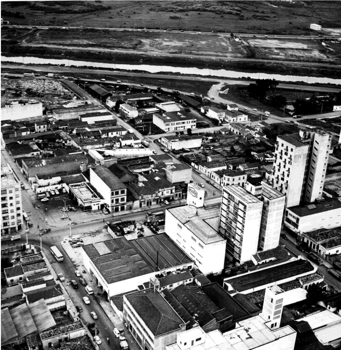
82 - Esquina da rua dos Italianos e rua Sérgio Tomás e, ao fundo, os dois lados da Marginal Tietê
