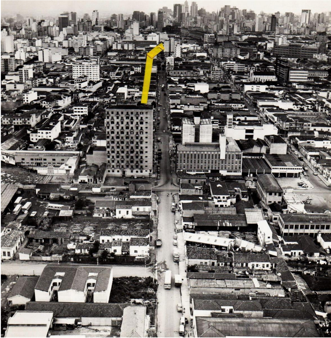
81 - Rua dos Italianos esquina, com a rua Javaés
