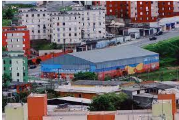
Fotografia 10 - Centro Cultural Arte em Construção - Vista Panorâmica
