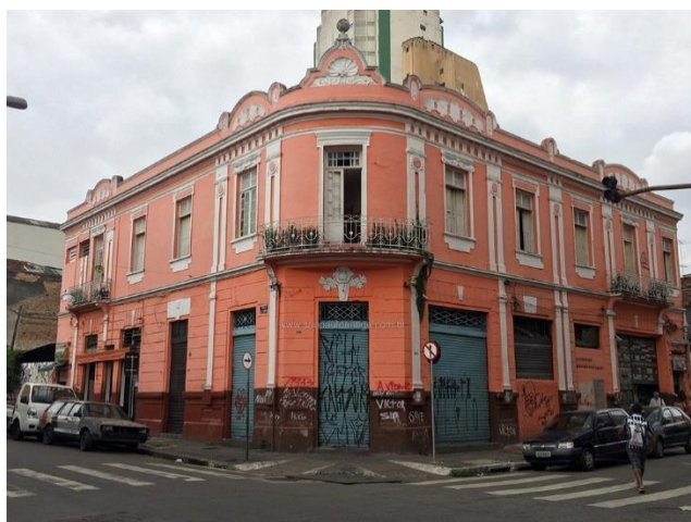
Prédio na Rua do Triunfo, 220, bairro da Luz, São Paulo.
