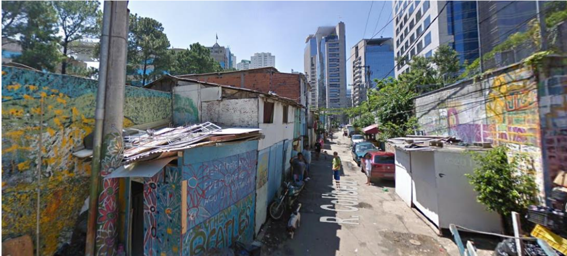
Favela da Funchal, na Rua Coliseu, antes da sua retirada.
