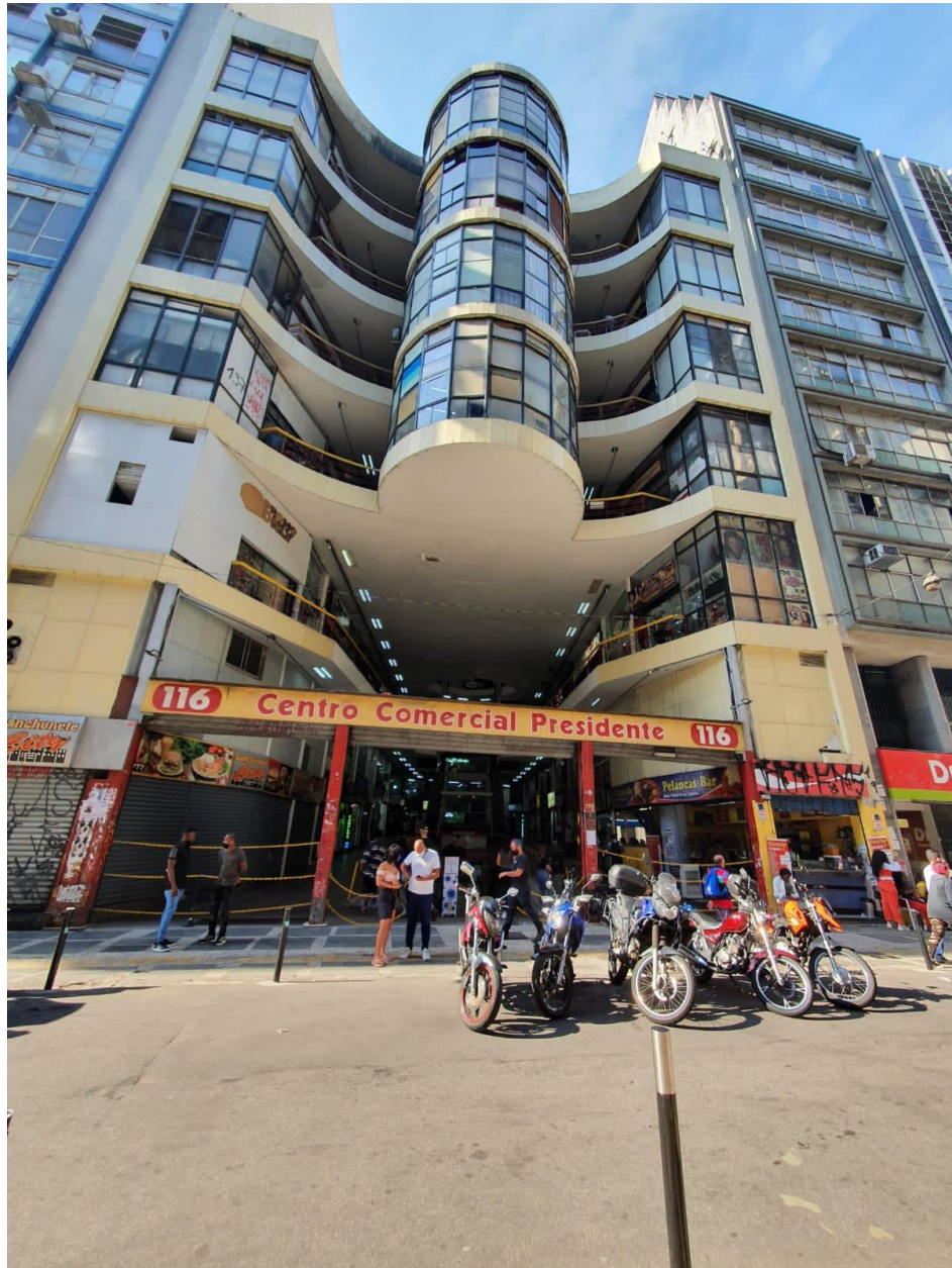
Figura 8 – Frente do prédio da Galeria Presidente
