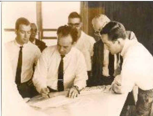
Eliezer Batista (ao centro) e grupo esboçando o projeto de construção do Porto de Tubarão, Vitória-ES, 1962.
