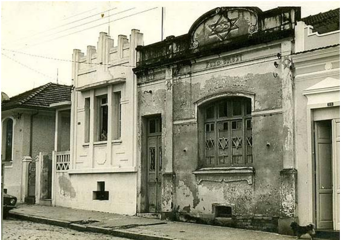
Figura 11 – Foto da primeira construção da Sinagoga Kehilat Israel , da Rua da Graça. Acervo: Revista Época São Paulo . Data de 1927.
