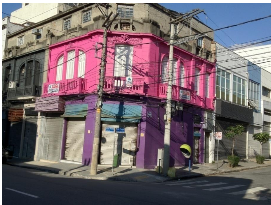
Figura 31 – Esquina Rua Professor Lombroso com Rua Silva Pinto. Único imóvel vago da rua preserva a sacada e a fachada do tempo da Rua Itaboca (antigo nome).
