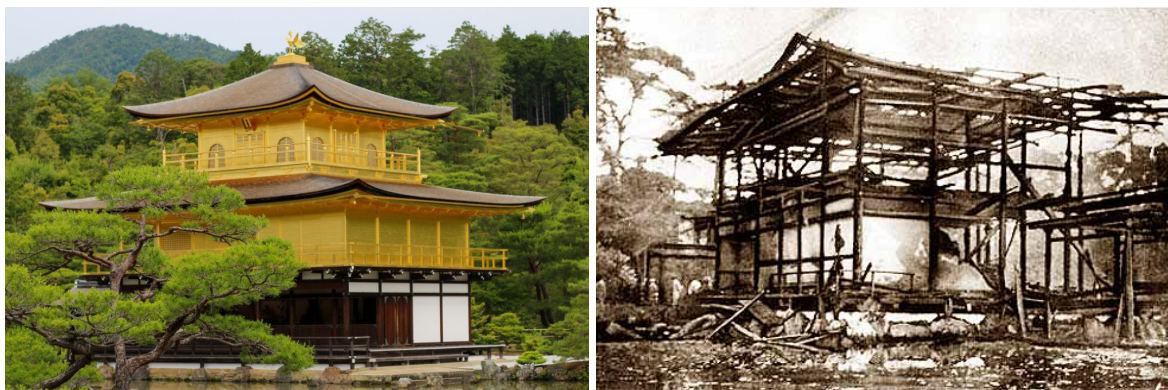
Figura 43 – Fotografias do Kinkaku-ji , localizado em Quioto. À esquerda, o templo em 2022. À direita, após ter sido destruído pelo incêndio em 2 de julho de 1950.
