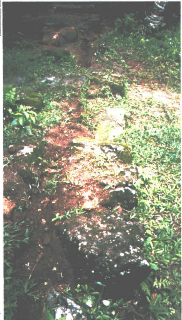
Foto 44 - Canaleta que sai do tanque da área de Decapagem I.
