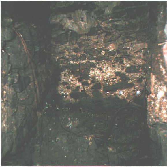
Foto 48 - Interior do duto de alvenaria de pedra argamassada.
