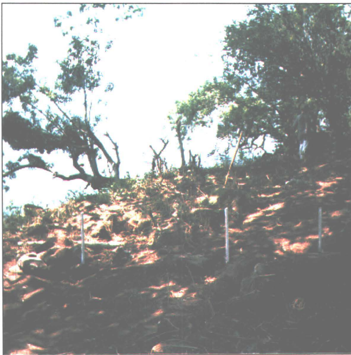
Foto 21 - Estaca demarcando o duto.
