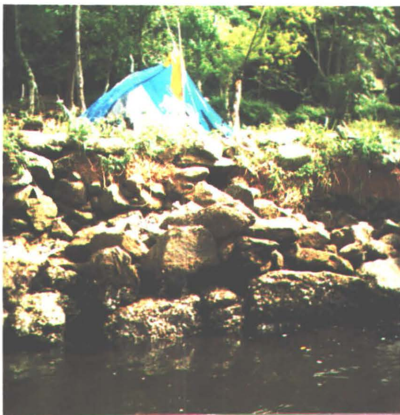
Foto 25 - Ocupação indevida pelos pescadores na área limpa a ser trabalhada.
