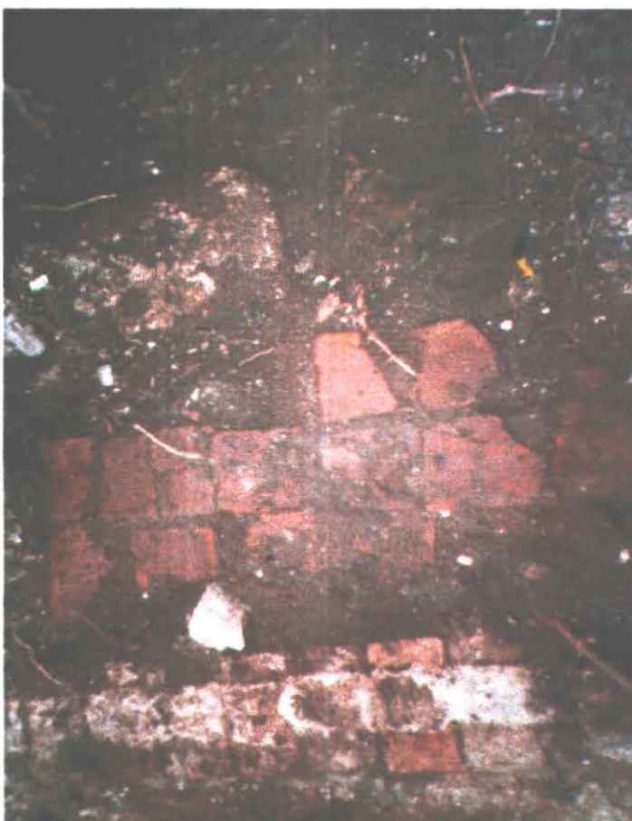
Foto 57 - Alvenaria de tijolos recente e piso de lajotas e pedrs originais.
