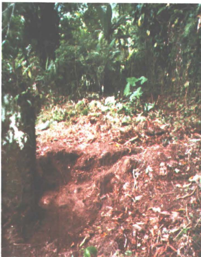
Foto 56 - Limpeza no entorno do Pilar da Estrutura I , Área B.
