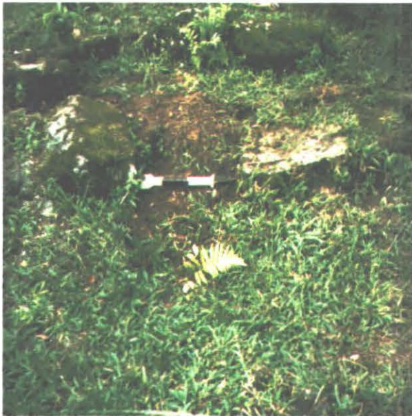
Foto 45 - Abertura da canaleta no sentido do Canal de Bertioga .
