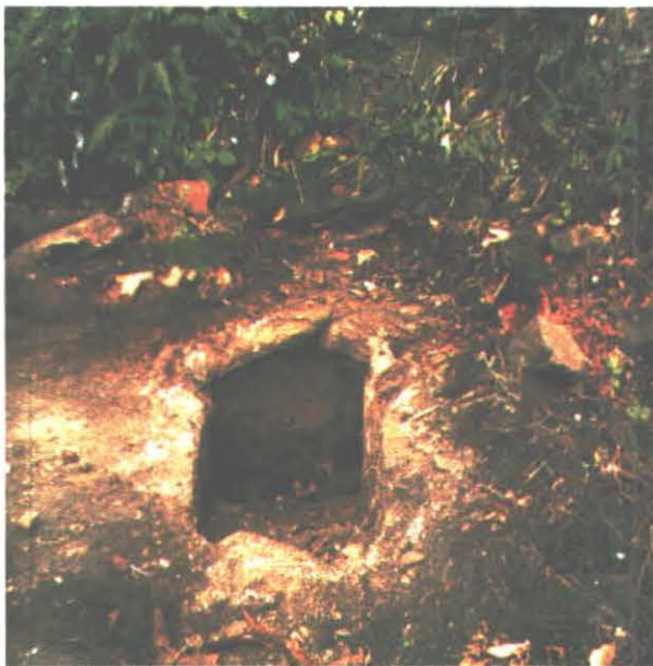
Foto 47 - Entrada do duto "área decapagem I" .
