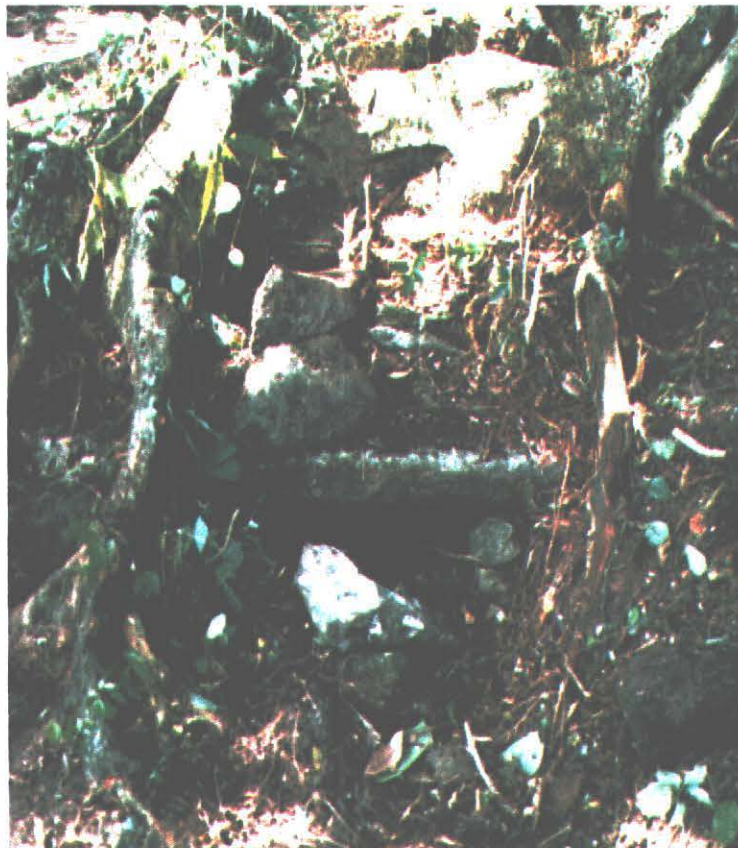
Foto 38 - Canaleta próxima à Estrutura II em sentido ao Canal (ao norte) após a figueira.
