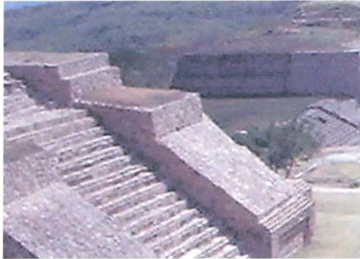
Fig. 61 Estrutura talude e plataforma – Monte Alban, Oaxaca
