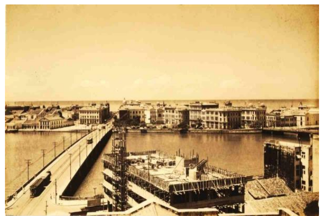
Ponte Buarque de Macedo, Recife Foto de Benício Whatley Dias (1940) Fonte: Fundação Joaquim Nabuco
