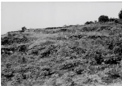
Muro de pedras em Brejinho, no sertão de Pernambuco.
