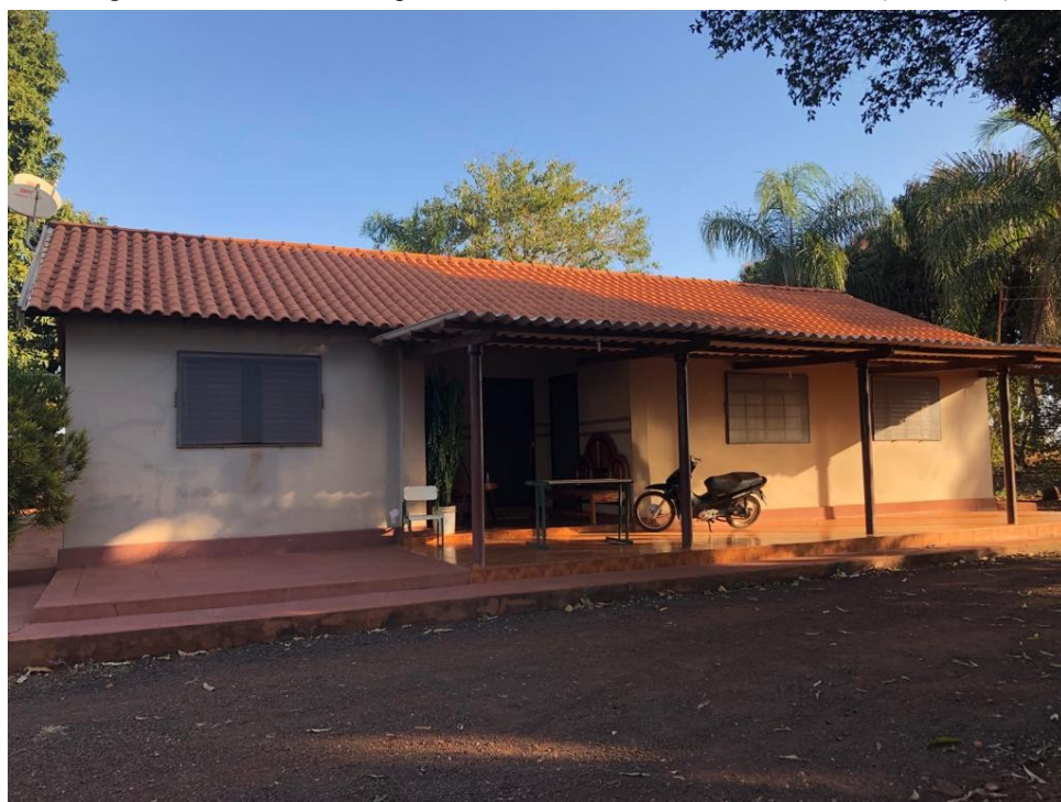
Imagem 27. Casa de colono preservada e reformada e ainda habitada (zona rural)
