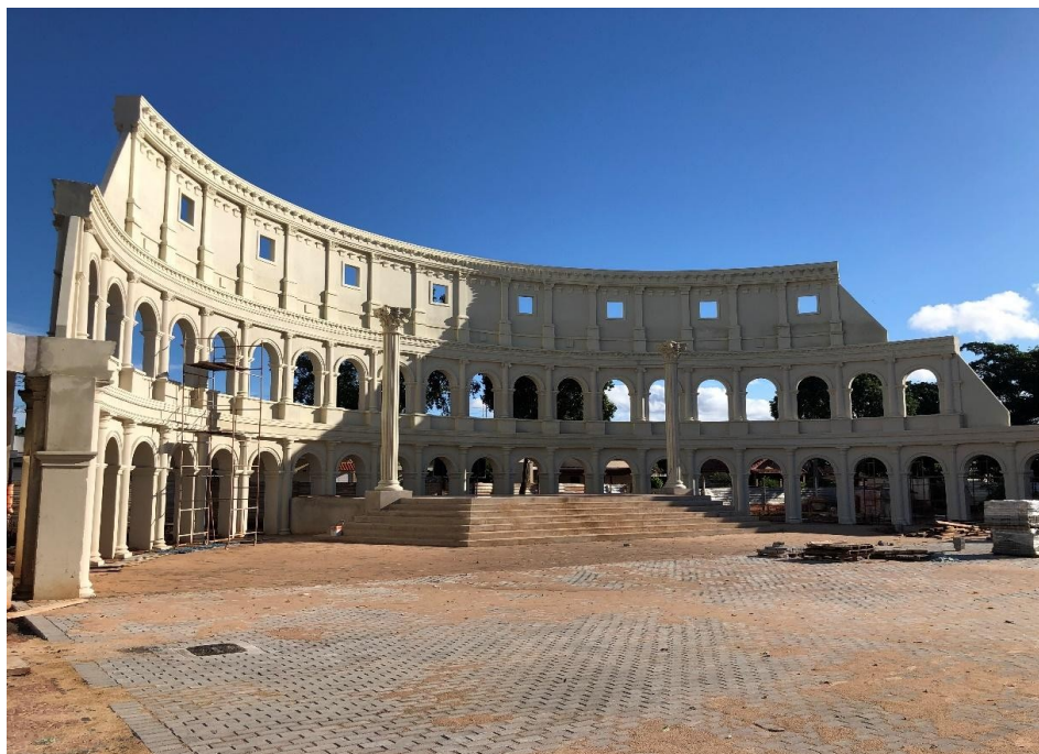
Imagem 11. Construção da Arena de Eventos Coliseu (localizada na Praça Roma)
