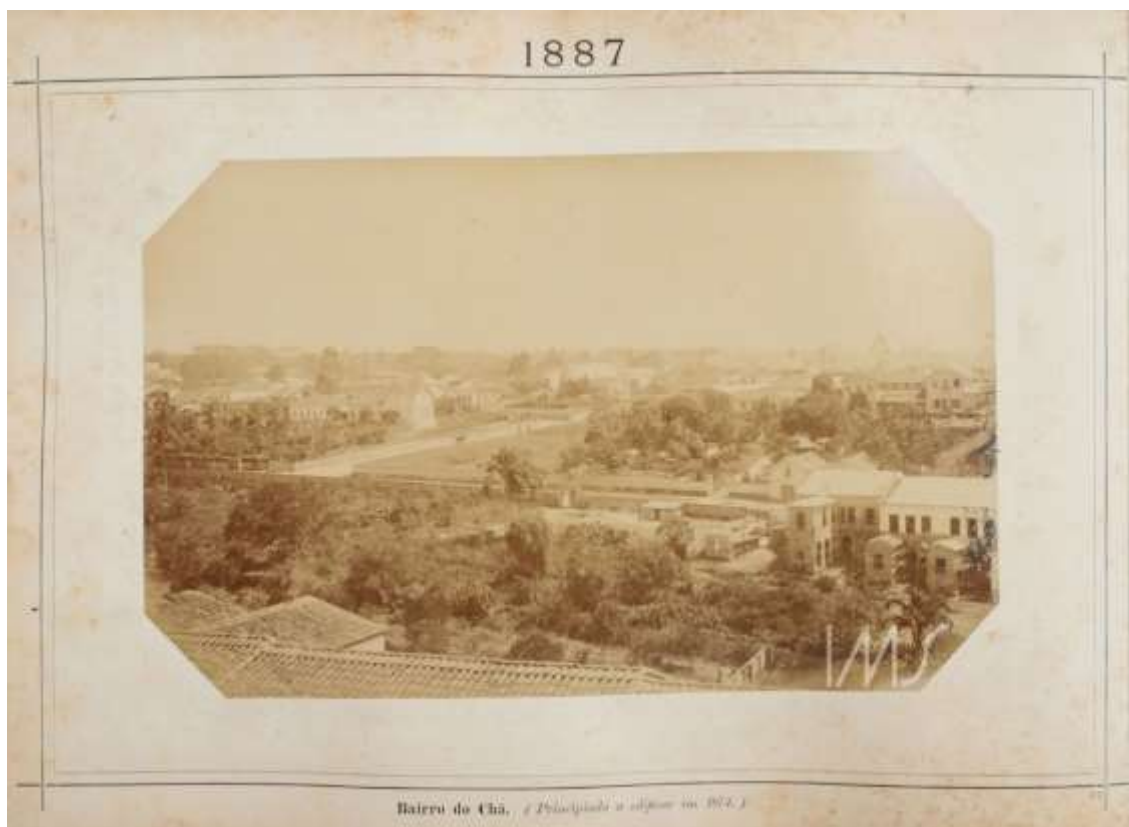
FIGURA 01: “Bairro do Chá (princiado a edificar em 1874)”. Fotografia de Militão Augusto de Azevedo, 1887, tirada a partir do Grande Hotel, localizado na rua São Bento. Nela, vemos horizontalmente a rua Formosa, cortada pela futura rua Barão de Itapetinga. Acervo do Instituto Moreira Sales (IMS).
