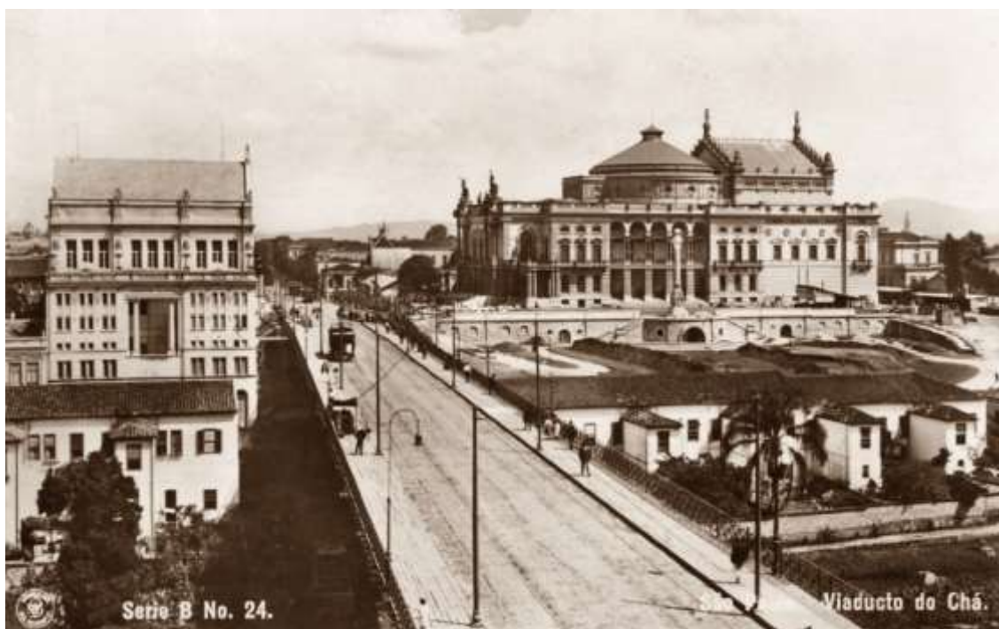
FIGURA 03: Postal n. 24, “Viaduto do Chá”. A fotografia possivelmente foi tomada do edifício do Grande Hotel, na Rotissiere Sportman . Do lado esquerdo ao fundo, o Teatro São José; do direito o Theatro Municipal; no primeiro plano, as casas da rua Formosa, lado ímpar. Guilherme Gaensly. Acervo do Museu Paulista.
