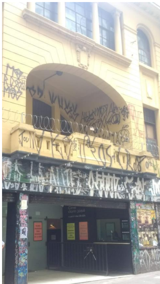
FIGURA 28: FACHADA CINE DOM JOSÉ 2018
