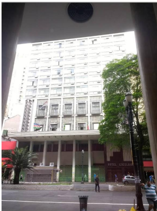
FIGURA 26: FACHADA DO CINE IPIRANGA 2018
