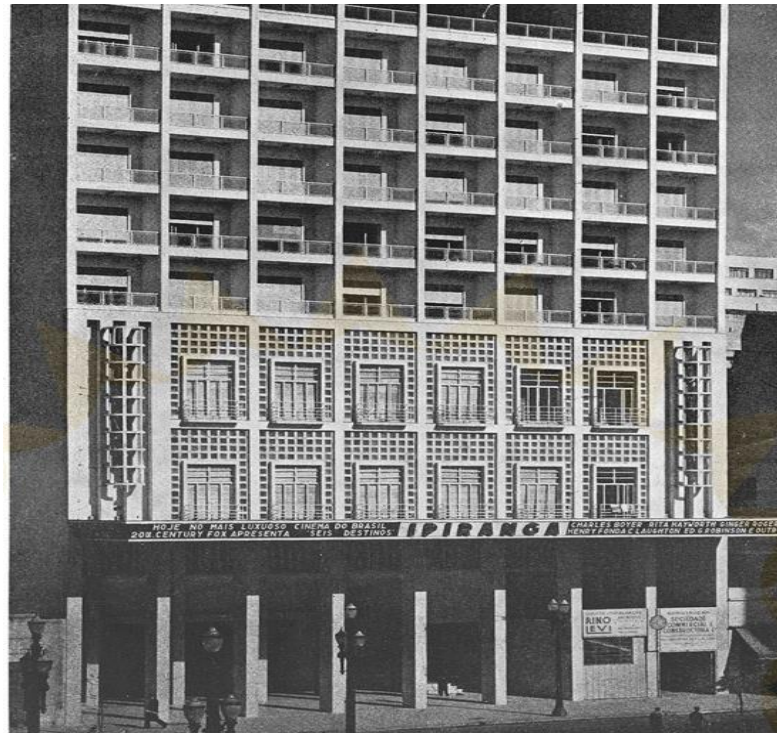
FIGURA 16: FACHADA DO CINE IPIRANGA
