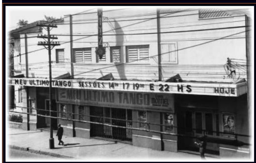
FIGURA 18: FACHADA DO CINE RITZ CONSOLAÇÃO
