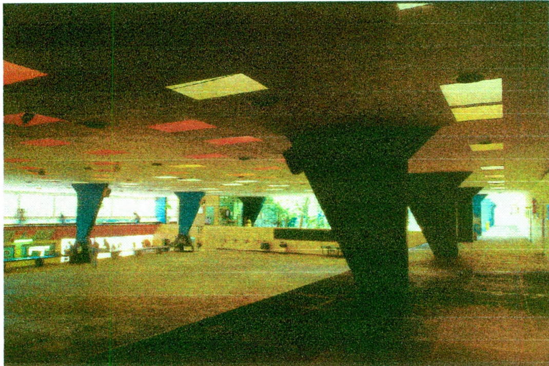
Fig.20 Iluminação Escola de Artigas
