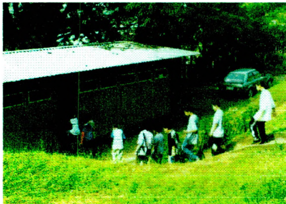
Fig 28 Salas em material metálico
