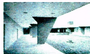
Ginásio de Guarulhos.
