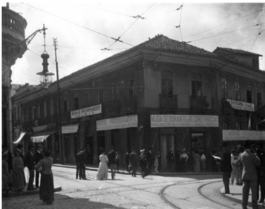
Figura 125 - O sobrado do Barão do Tietê por volta de 1906, com cartazes indicando sua iminente demolição. Fotografia de Aurélio Becherini, 1906/1907. Acervo Fotográfico do Museu da Cidade de São Paulo.
