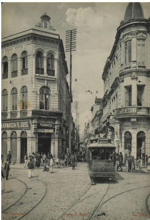
Figura 119 - A esquina do largo de São Bento com a rua de mesmo nome após a construção do novo edifício da esquina à direita, que contava com um edifício anexo nos números 93 e 95. Fotografia por Guilherme Gaensly. São Paulo, SP, [1902?]. 22,4 x 28,2cm. Acervo BN, RJ.
