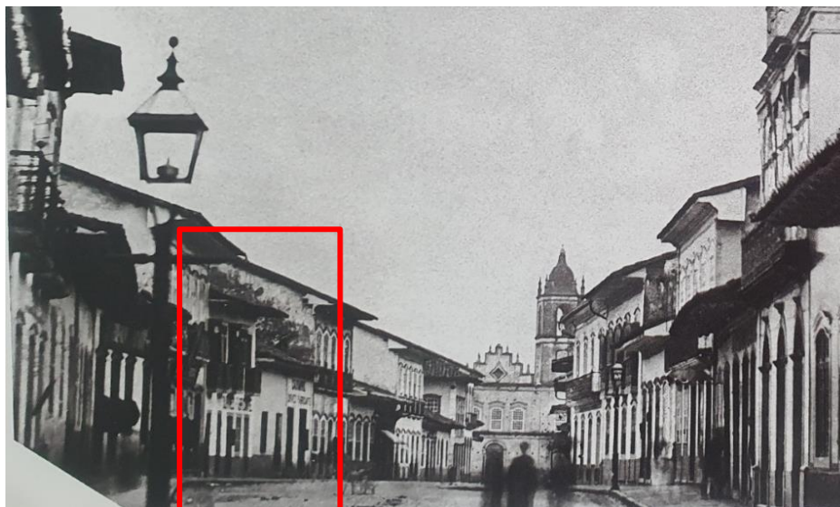
Figura 83 - Nesta fotografia do mesmo trecho da rua da Imperatriz, em 1862, vemos que onde seria instalada a livraria Garraux, havia imóveis menores, o que indica que seu sobrado era provavelmente uma construção recente. Militão Augusto de Azevedo, 1862 (Fernandes Junior et al., 2012, p.144).
