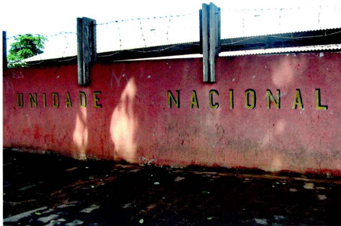
Imagem 27. Muro do Hospital Militar de Luanda. 1976.
