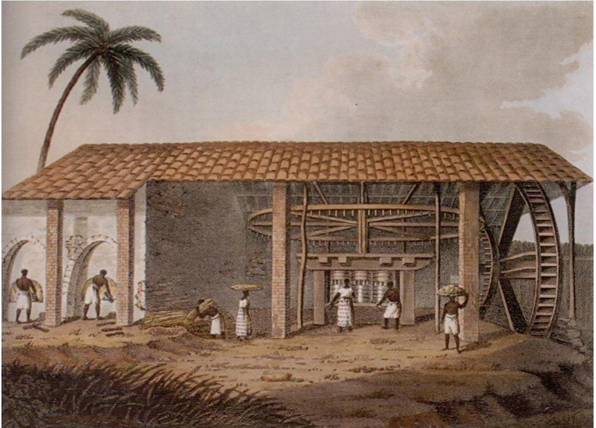
Figura II.3 – Moenda de cana-de-açúcar movida a água, 1816
