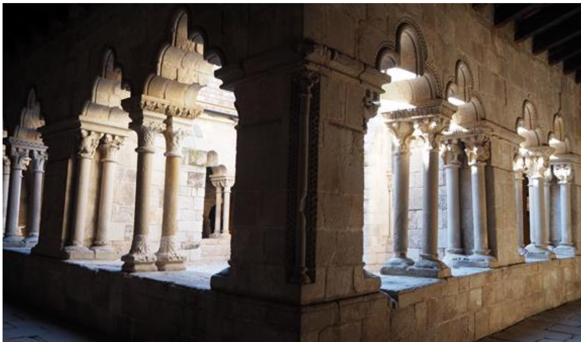
Fig.108 Pilar de ângulo nordeste do claustro
