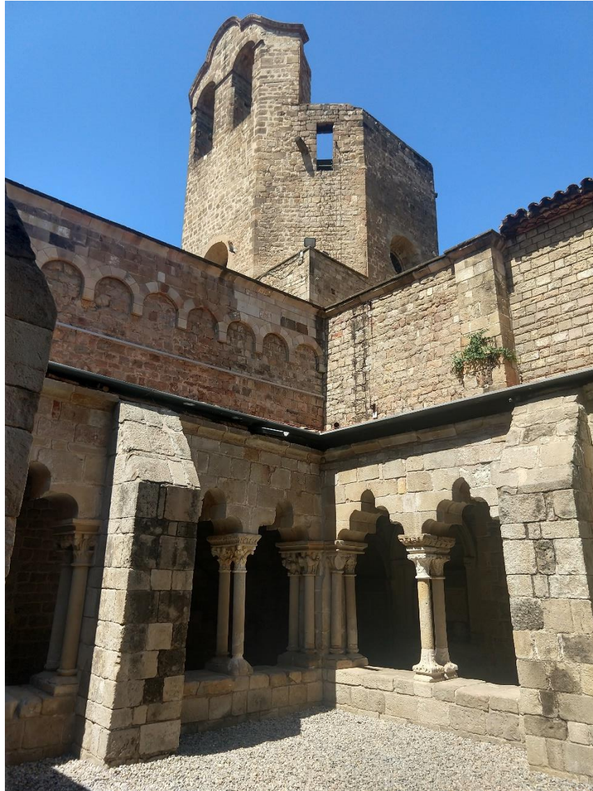
Fig. 18 Vista interna do claustro: parte das galerias norte e leste e contrafortes. Galeria norte-arcos trilobulados; galeria leste – arcos polilobulados (cinco lóbulos).
