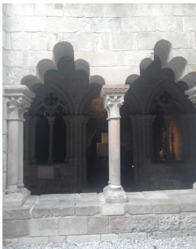
Fig. 112 Setor sul da galeria leste – entrada da sala capitular.
