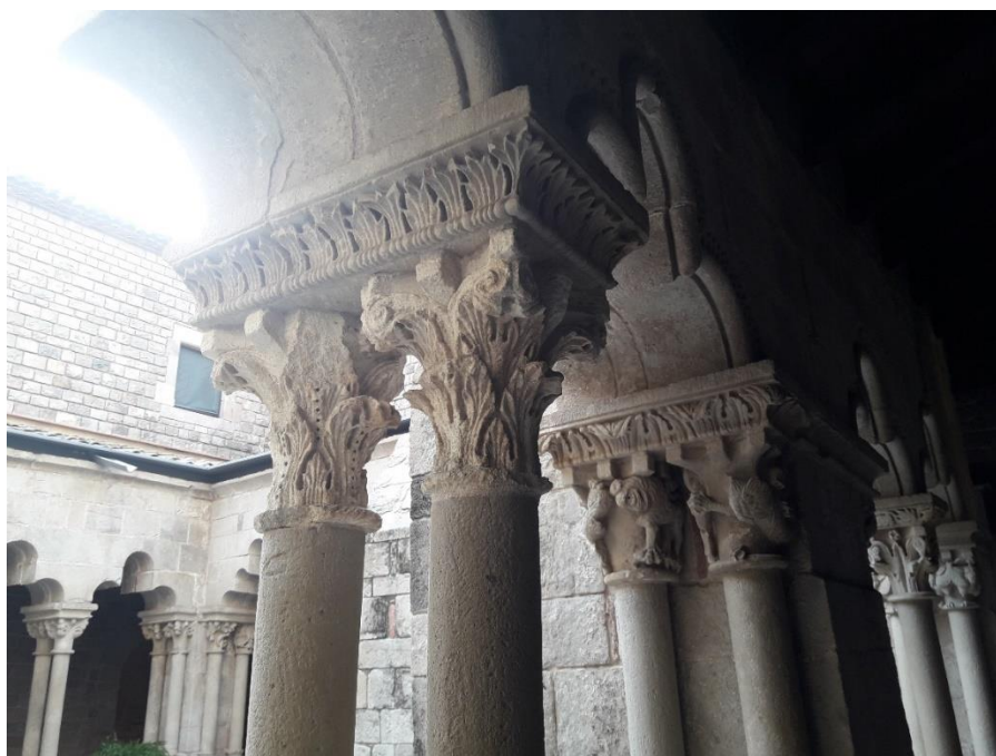
Fig 111. Galeria norte, setor próximo à igreja
