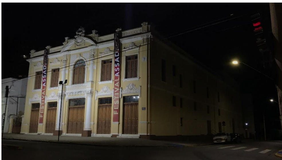
Fotografias 192 a 203 - Vista angular da fachada, pormenores dos ornatos restaurados por Romeu P. Buzon, e fachada principal, em período atual.
