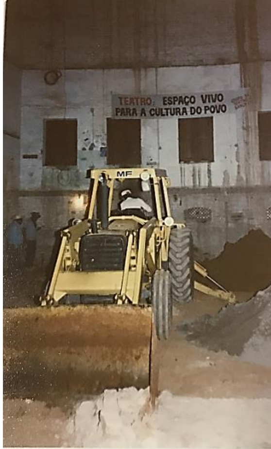
Fotografias 179 e 180 - Fase inicial de obras internas c.1987/1988.
